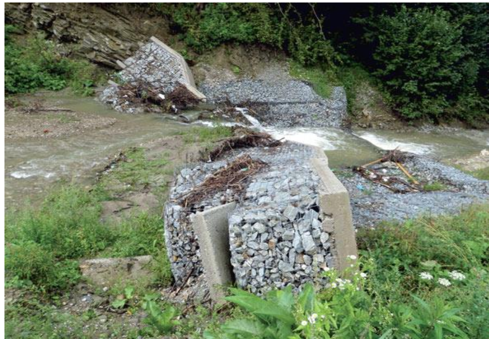
Detaily prevalenej hrádze havarovaného poldra nad obcou Snežnica
