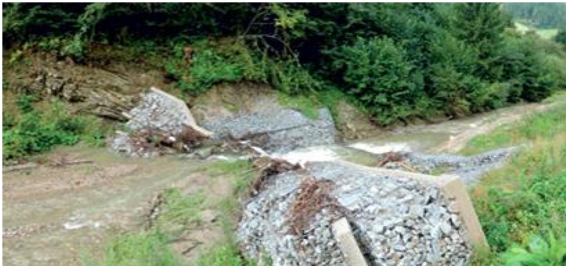
Detaily prevalenej hrádze havarovaného poldra nad obcou Snežnica
