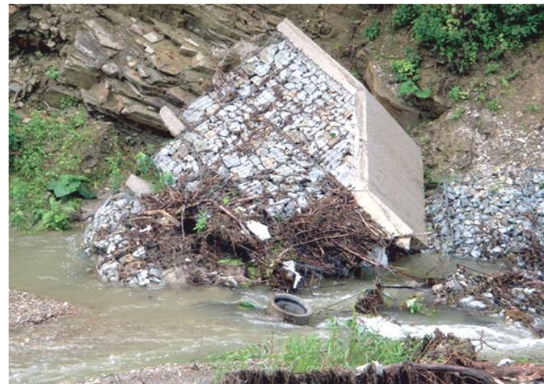
Detaily prevalenej hrádze havarovaného poldra nad obcou Snežnica
