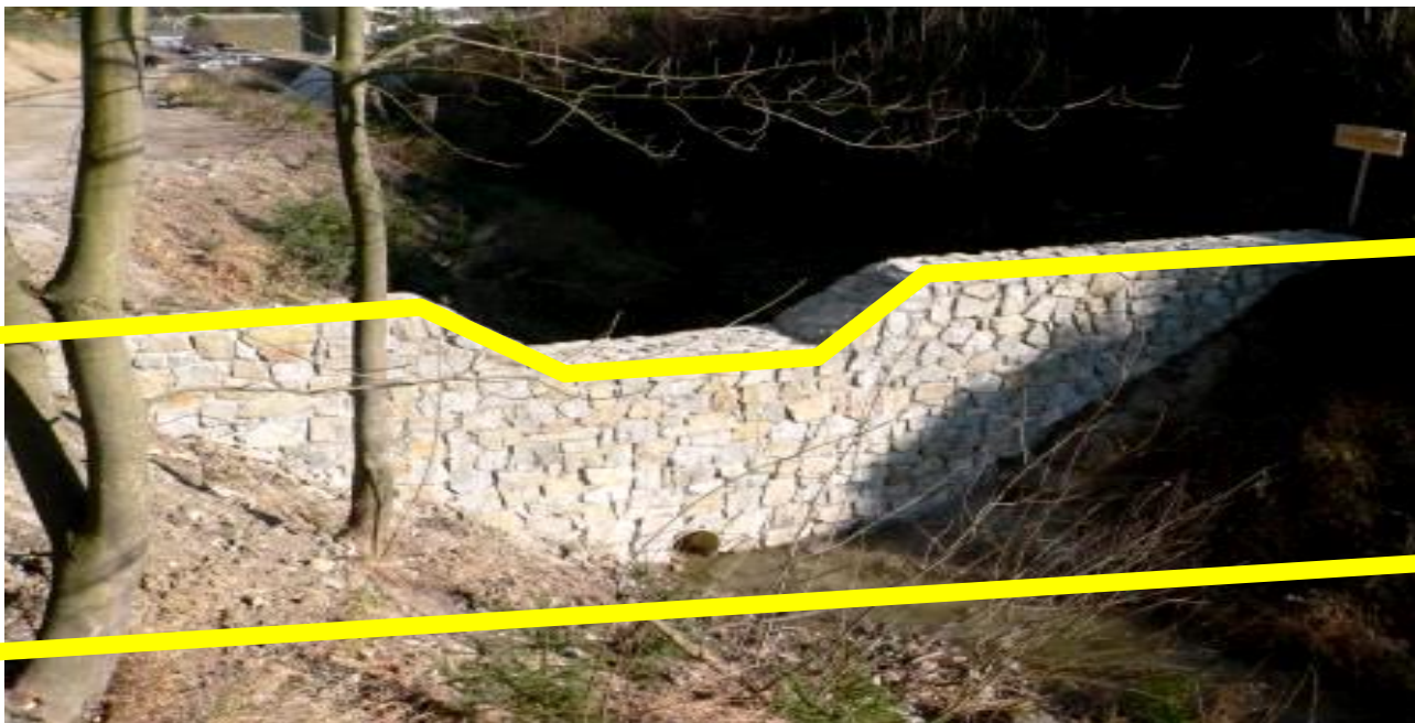
Ukotvenie kontrukcie (krídiel) do rastlého podložia brehov
