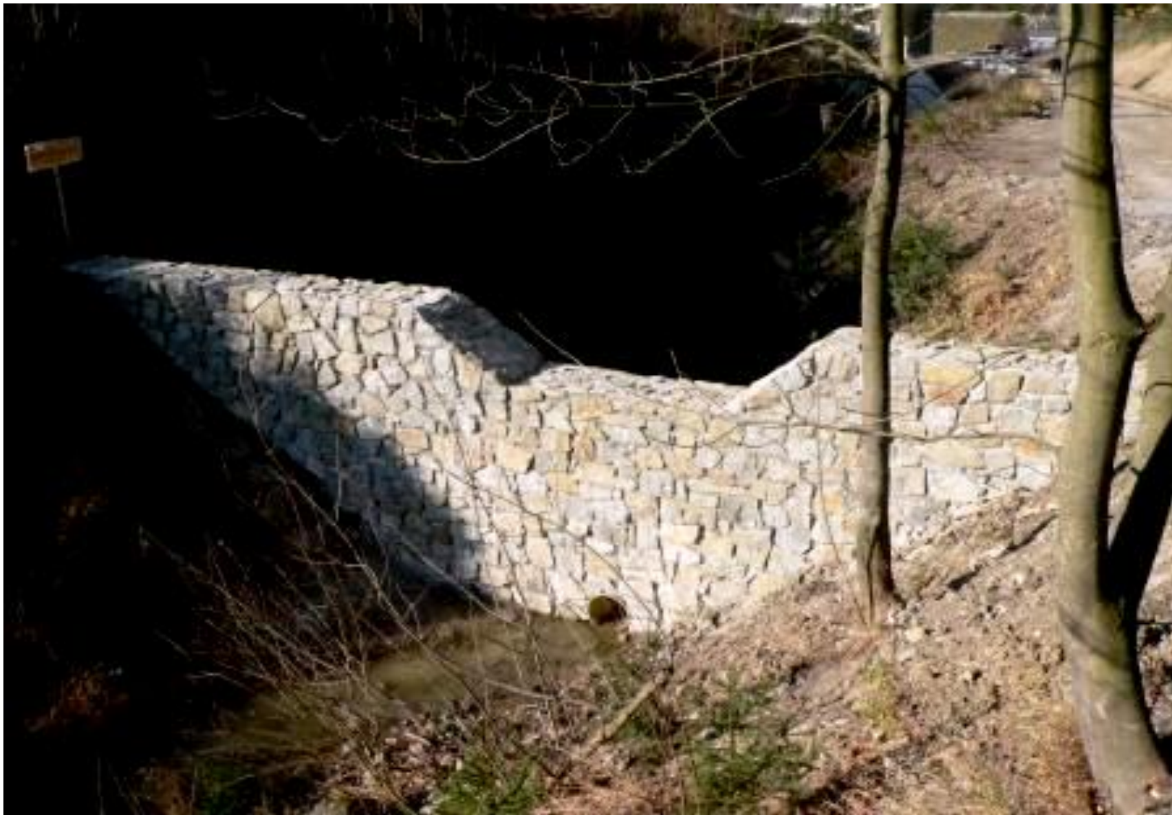
Kamenná prehrádzka s dnovým výpustom bez vývaru
