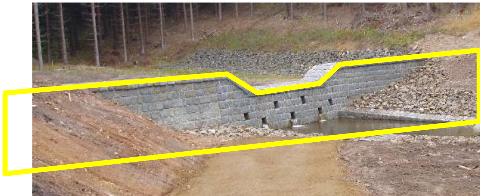
Ukotvenie kontrukcie (krídiel) do rastlého podložia brehov
