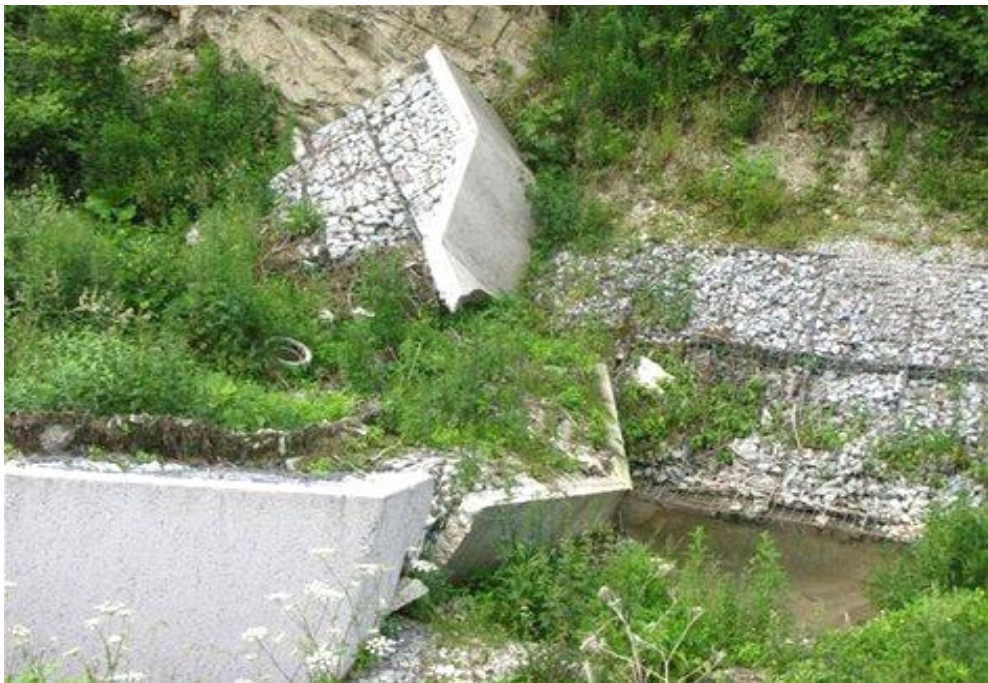
Detaily prevalenej hrádze havarovaného poldra nad obcou Snežnica
