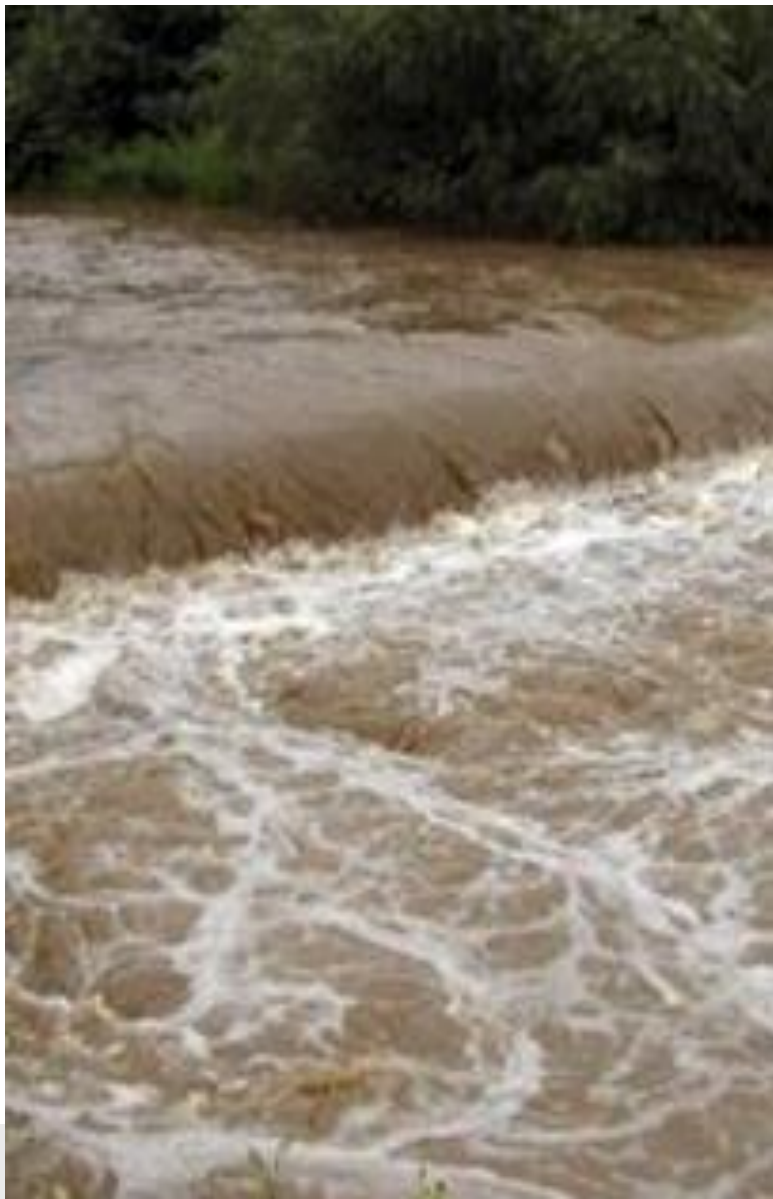
Stupeň na rieke s vývarom Funkcia vývaru
