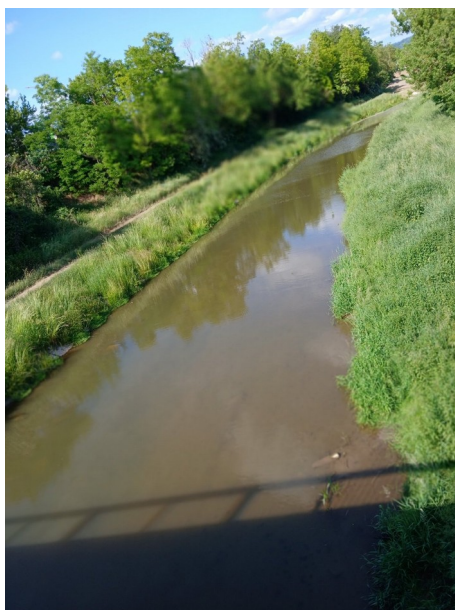
Príloha č. 1: Koryto rieky Štiavnica pred realizáciou projektu
