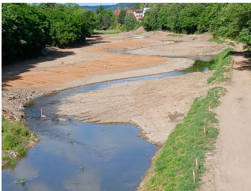
Príloha č. 2: Koryto rieky Štiavnica pred dokončením projektu
